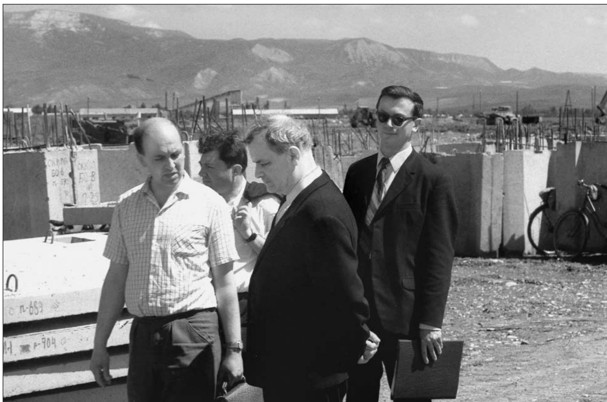
На стройплощадке РАТАН-600 с Ю.Н.Парийским и В.А.Мининым. Июнь 1969 г.
