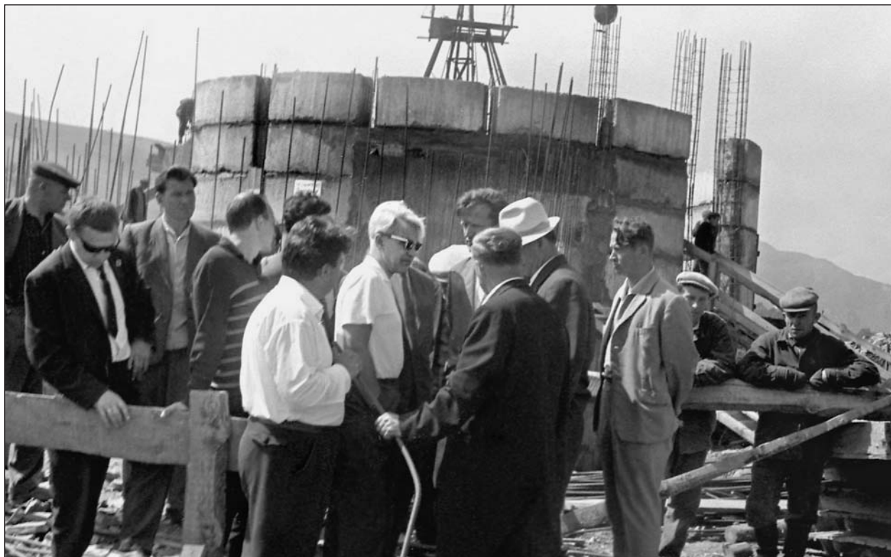
Стройплощадка БТА. Июль 1966 г.
